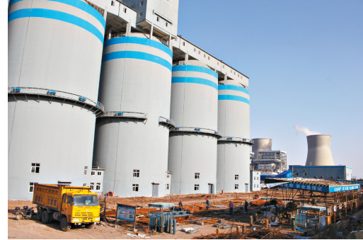
配煤中心加紧施工即将投产
