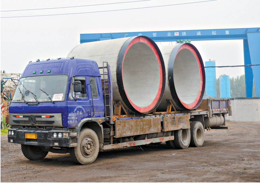
6月23日,一辆平板车承载着检测合格的管材从生产厂家驶向湛南顶管工程施工现场。 本报记者 王尧 摄
