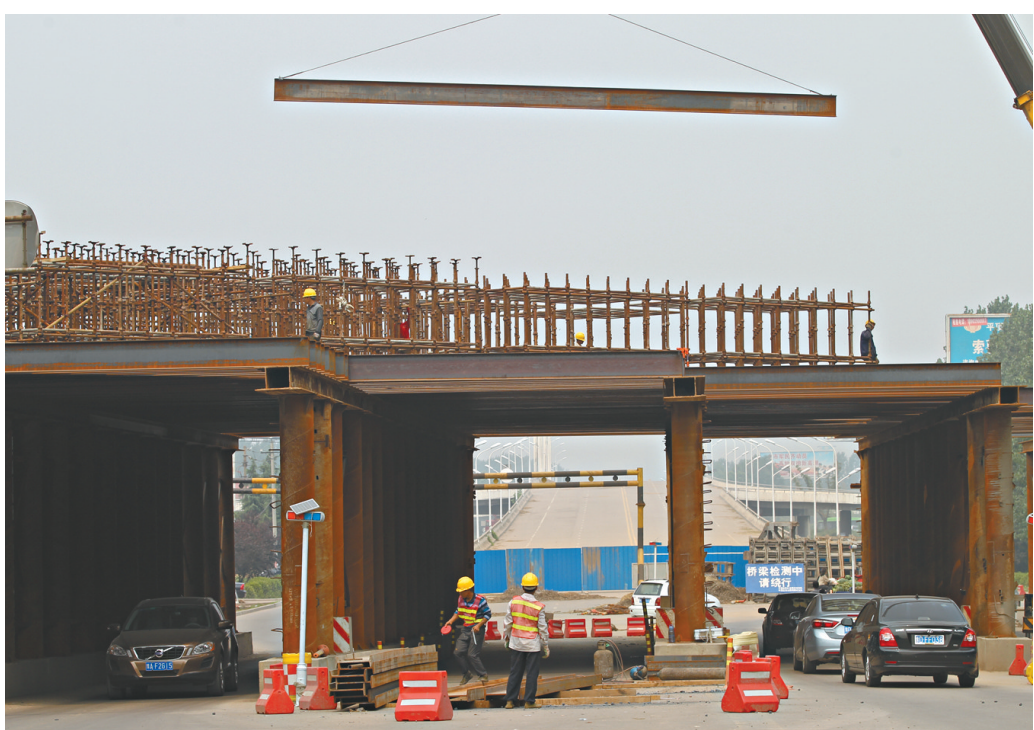
6月19日,施工人员在市区建设路东段修建拱桥。孟平铁路复线工程于去年3月开工,线路全长99.3公里,跨建设路拱桥跨度64米、高5.57米。在保桥下车辆不间断通行的情况下,施工人员进行昼夜施工,确保工程按时完工。本报记者 李志勇 摄
