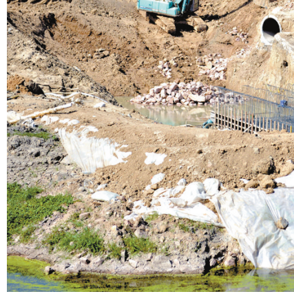
姚孟村段征迁工作完成,施工作业面全部打开。
