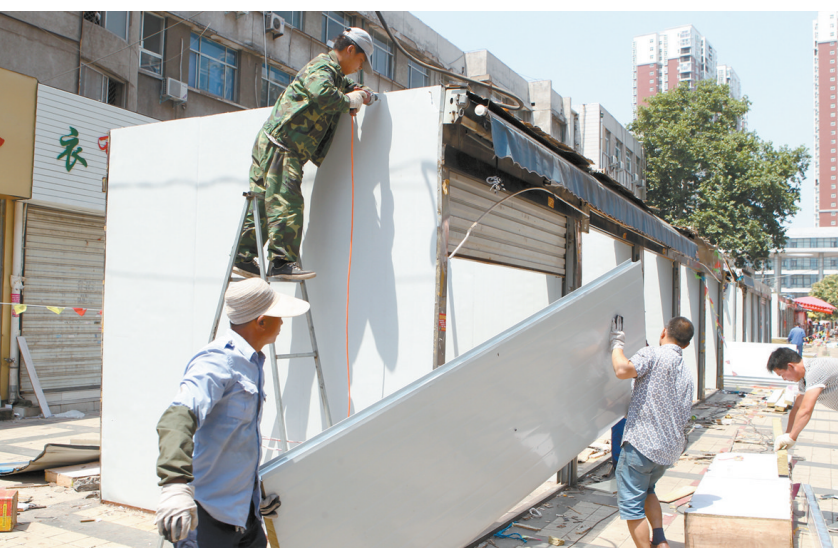
↑6月11日,施工人员在市区凯撒广场更换商铺墙体。凯撒广场地处闹市,广场内部分建筑材料存在安全隐患。为了避免发生安全事故,市市场发展服务中心凯撒广场管理处于本月6日开始组织施工人员进行广场内违章建筑全部拆除,预留消防通道,并将所有商铺的非阻燃建筑材料更换为阻燃的岩棉板墙体。本报记者 姜涛 摄
