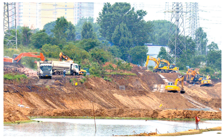
6月5日,施工人员在驾驶挖掘机、自卸车在湛河治理工程国铁桥至许南路标段大营桥附近河道南岸开挖、清运土方。本报记者 王尧 摄
