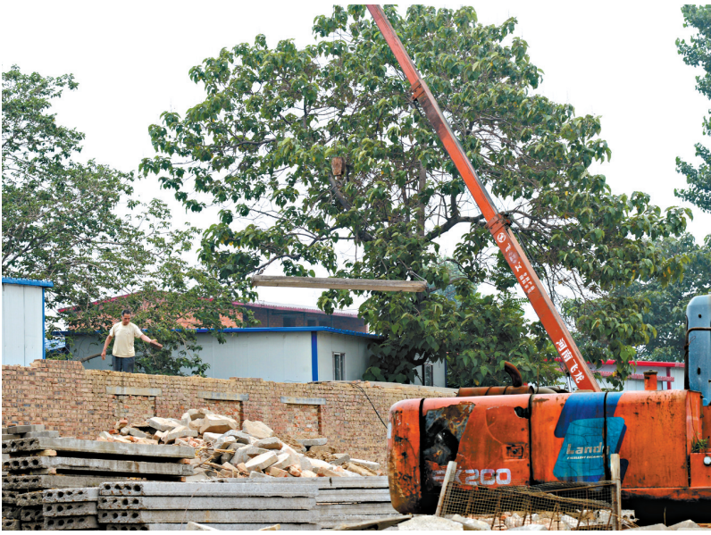
施工人员指挥吊车帮助卫东区淇河街道大营村群众拆除房屋上的楼板和砌块等可以再次利用的建材提前拆除安置。
