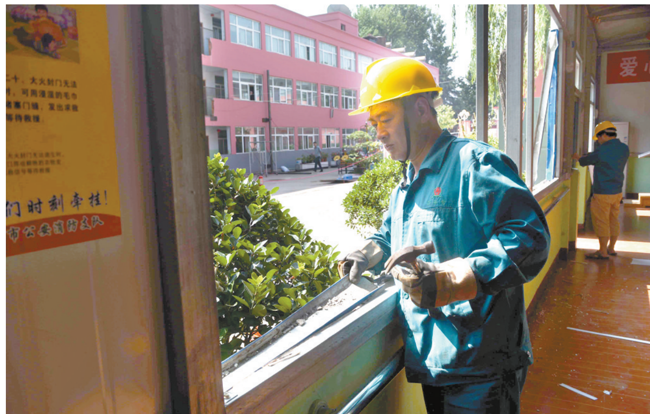
拆除易燃彩钢房
