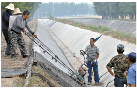
硬化二支渠护坡
