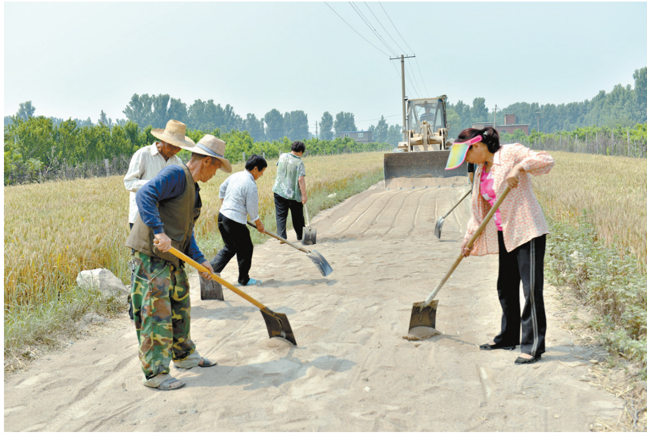
个人出资修路生产道路
