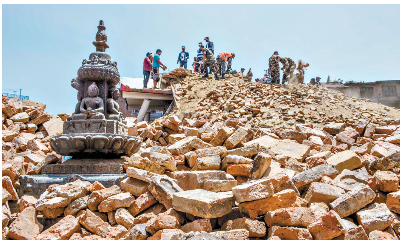
5月12日,在尼泊尔古城帕坦,当地居民清理被地震破坏的房屋。与加德满都一河之隔的尼泊尔古城帕坦受地震影响,大量楼宇与古迹被破坏。 新华社发
