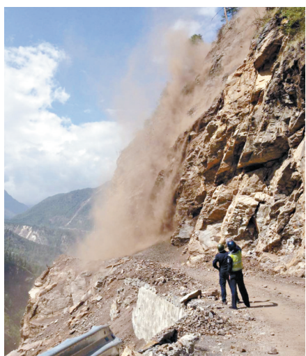
5月12日,吉隆镇通往吉隆口岸的路段发生塌方(手机拍摄)。 新华社发
