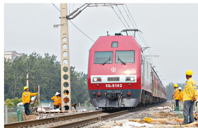
施工、行车两不误
