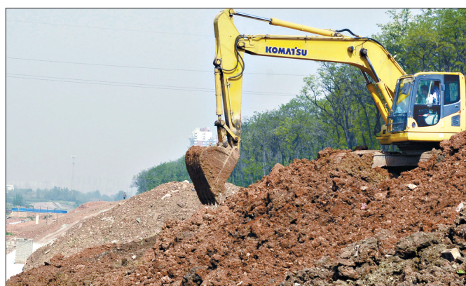
4月30日,一位工人驾驶挖掘机在湛河治理工程BT段施工现场开挖土方。
