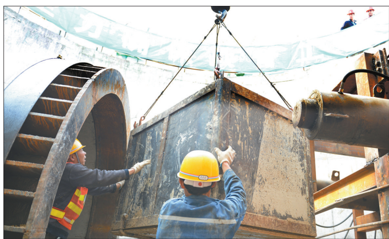
4月30日,湛南顶管施工人员配合龙门吊将开挖出的泥土运出工作井。
