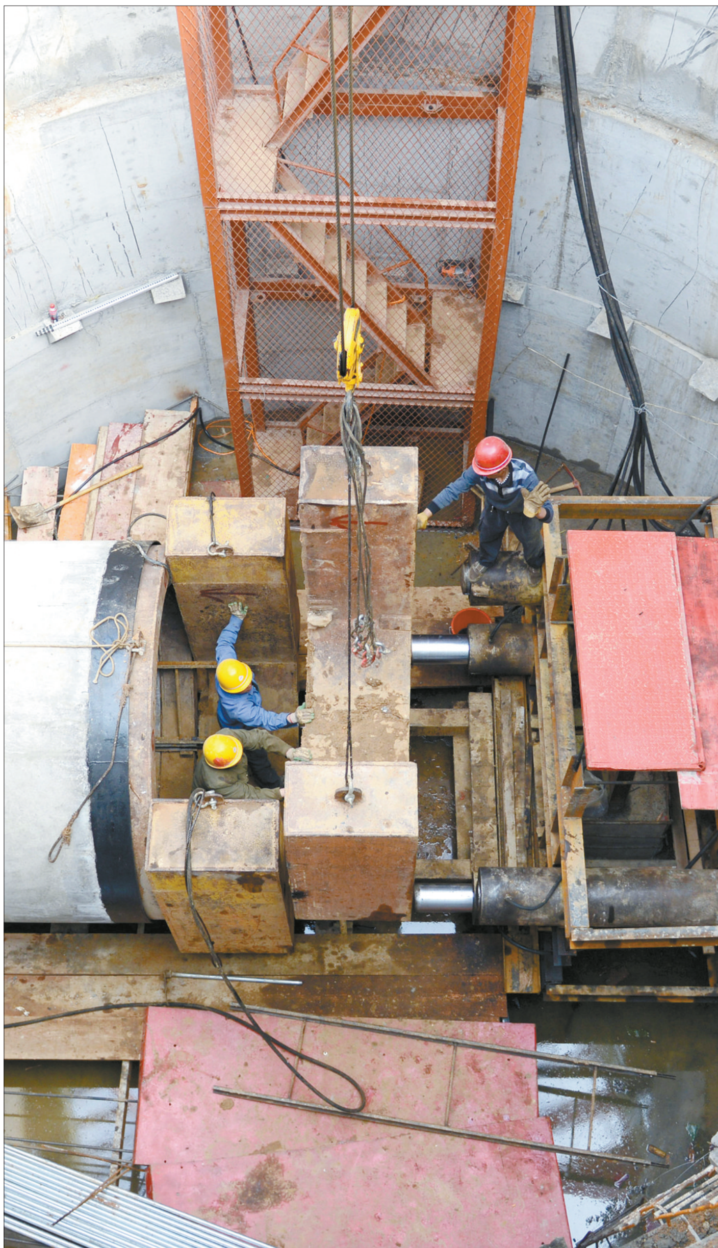
4月30日,湛南顶管施工人员配合龙门吊将顶铁安放在千斤顶前端。
