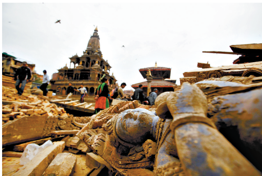
4月26日,在尼泊尔帕坦,杜巴广场佛像倒塌,一片狼藉。
