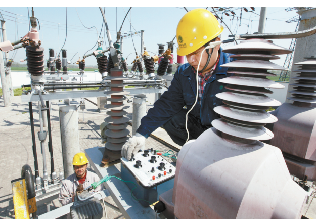
4月24日,技术人员在35千伏康村变电站检测维护设备。为积极备战夏季用电高峰,叶县供电公司从4月中旬开始组织技术人员提前
