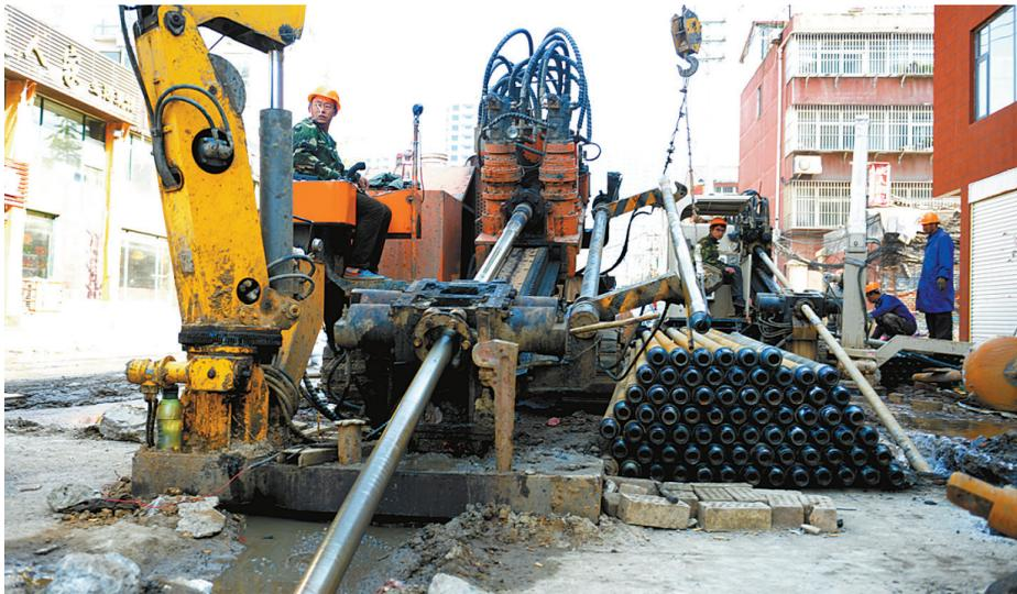
4月23日,两台钻机同时开展定向穿越作业。平顶山城市集中供热管网扩建一期工程是市重点工程,北线供热管网覆盖老城区矿区铁路以南,姚屯大道以北,西环路以东,光明路以西区域。在该项目北线长青路支管道铺设
