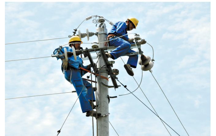
4月18日,检修人员正在施公司加强设备巡视应对高温高工。中月中旬以来,石龙区供电公司密切监视电网设备运行情况。牛献廷 摄
