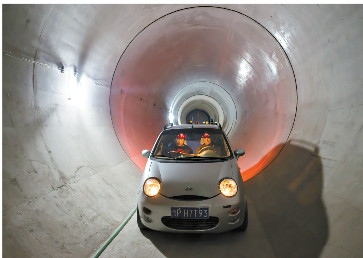
4月17日,工作人员驾车在东干渠隧洞内巡查。当日,记者从北京市南水北调办公室获悉,北
