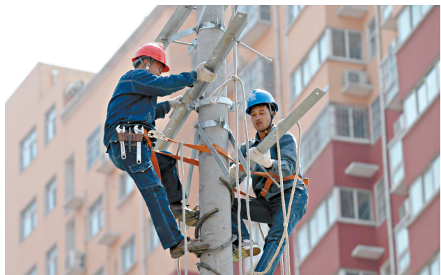
4月13日,施工者在平煤神马集团四矿安置小区优胜小区架设线缆组件。为保障夏季用电,平顶山供电公司在此处新架设10千伏电力线缆。 本报记者 李志勇 摄
