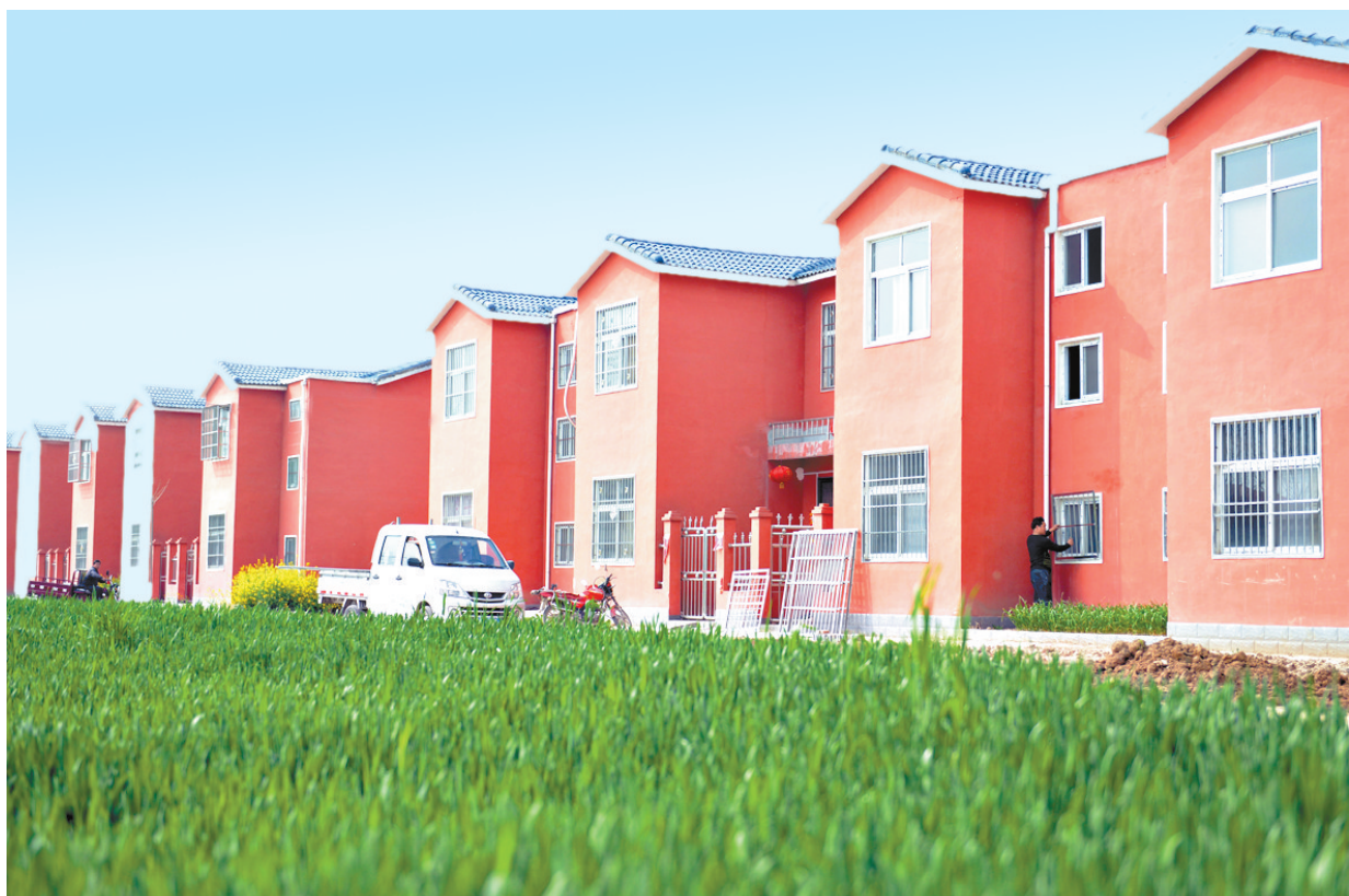
4月10日,水寨村一村民在建成不久的新居前安装防护网。
