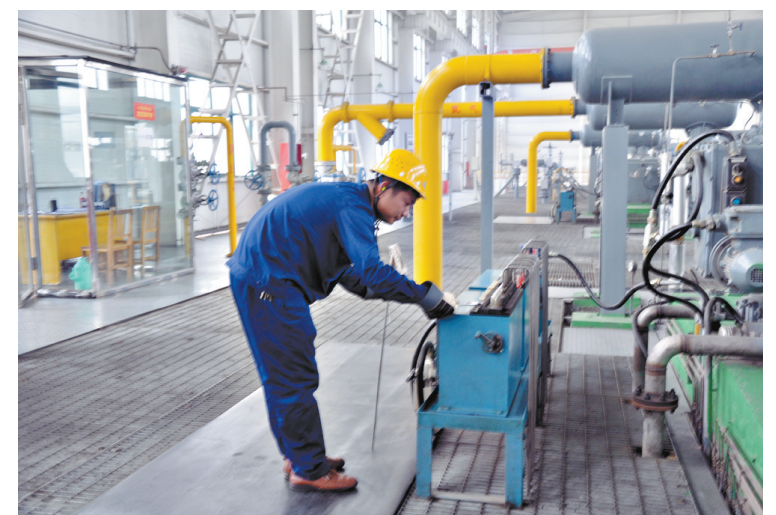
3月18日,工作人员在甲醛自动化车间检修设备。
