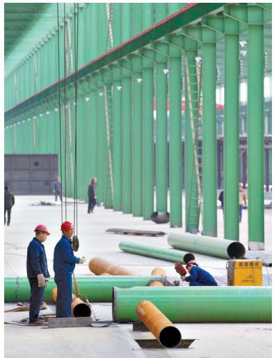
翔隆不锈钢项目进入设备总安装
