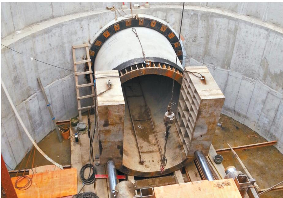
3月6日上午，在市区开源路滨河桥东岸南岸工地，施工机械在吊装土方。据了解，为有效保护现有绿化，减少施工给群众带来的不便，工程人员采用了顶管施工法。
