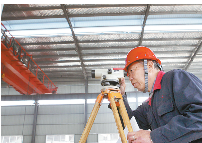
3月5日,技术人员在新建厂房内找测量安装设备。年初以来,宝丰县中原不锈钢年产110吨彩色不锈钢生产线加紧安装设备,预计本月底调试生产,年销售额可达200亿元。本报记者 李志勇 摄
