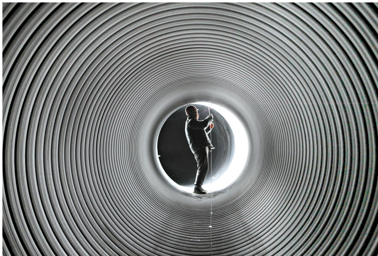
波纹管施工忙
