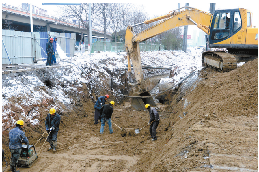
1月28日上午，工人们在湛河综合治理工程高庄沟至李苗路标段乌江河北干管施工现场对管道铺设到位的管沟进行回填。本报记者 王尧 摄
