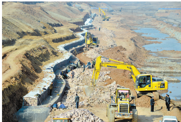
左图：施工中的湛河治理工程稻香路至凌云路段 右图：治理开工前的湛河稻香路至凌云路段河道
