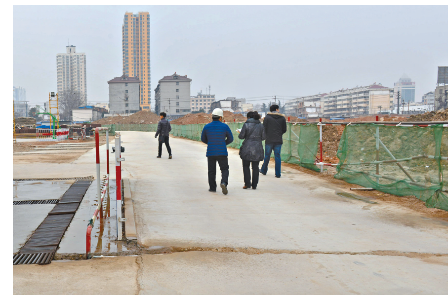
名门世家项目建筑工地除对工地道路进行硬化、设立车辆冲洗平台外，近日还设置了防尘网。
