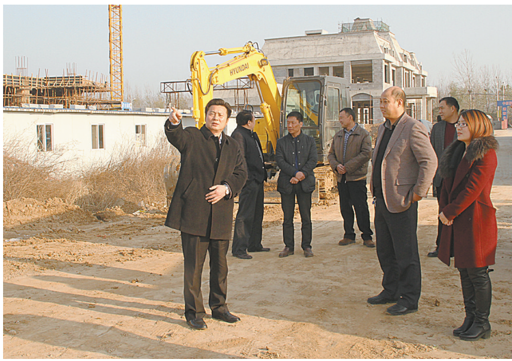
近日,叶县县委书记田瑞(左一)在中原国际盐湖度假小镇察看项目建设进度。据悉,该项目一期于2014年3月开工,投资6.8亿元,建筑面积9.53平方米,预计2016年5月投入运营。孙彬彬 摄
