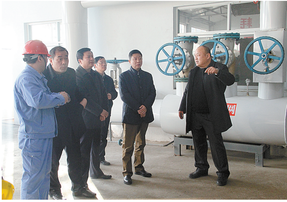
上月29日,叶县县长古松(右二)到位于叶县产业集聚区内的河南蓝光电厂的集中供热换热站察看,认真听取供热项目介绍。据了解,该项目由叶县正源供热有限公司承建,总投资1.8亿元,将充分利用河南蓝光电厂蒸汽余热资源为叶县居民供热。王梦琪 摄
