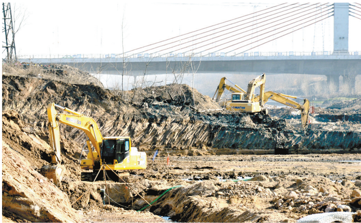
1月4日,施工人员在驾驶挖掘机在淇河治理工程国铁桥至许南路标段开挖土方。
