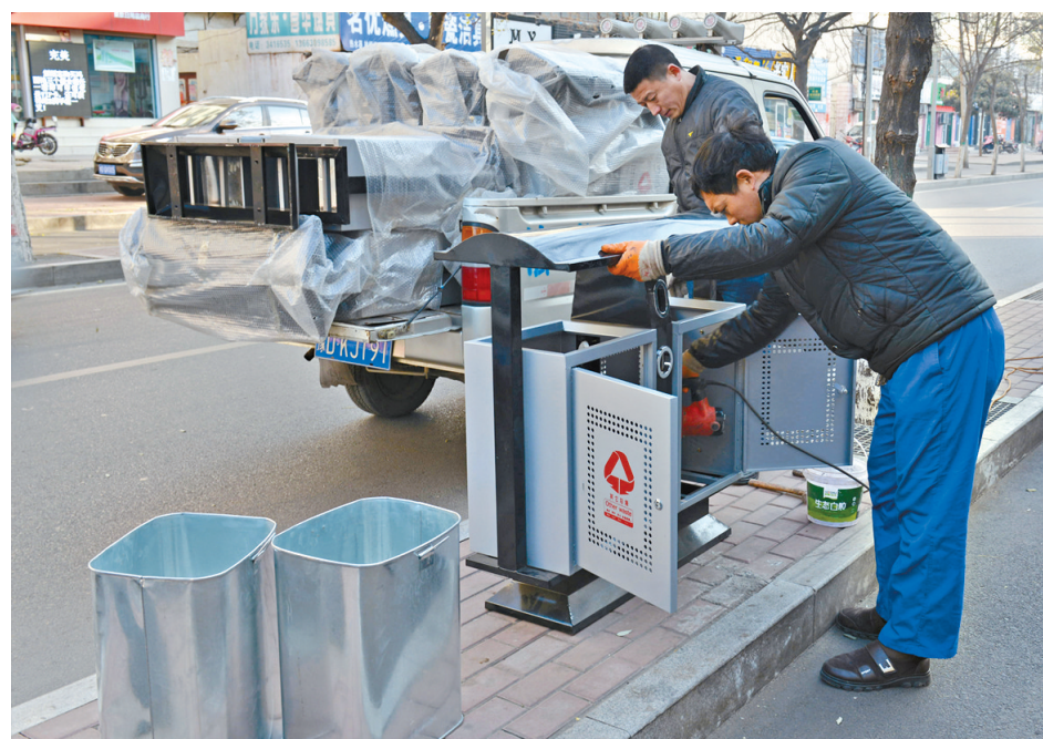
2014年12月31日,湛河区环卫局工作人员在市区湛南路中段安装分类收集垃圾箱。为了更好地服务行人和周边居民,湛河区环卫局本周将在湛南路两侧集中安装150个分类收集垃圾箱。 本报记者 牛智广 摄
