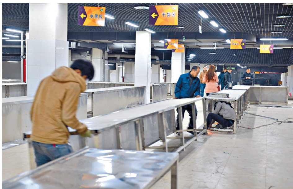
市场工作人员正在安装不锈钢货架。
