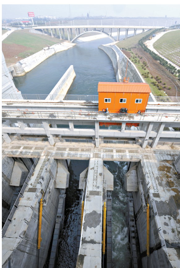
这是河南省淅川县南水北调中线工程陶岔渠首枢纽(10月21日摄)。新华社记者 李博 摄
