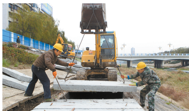
12月3日,施工人员在铺设盖板。湛北暗涵改造工程是湛河治理工程的重要组成部分
