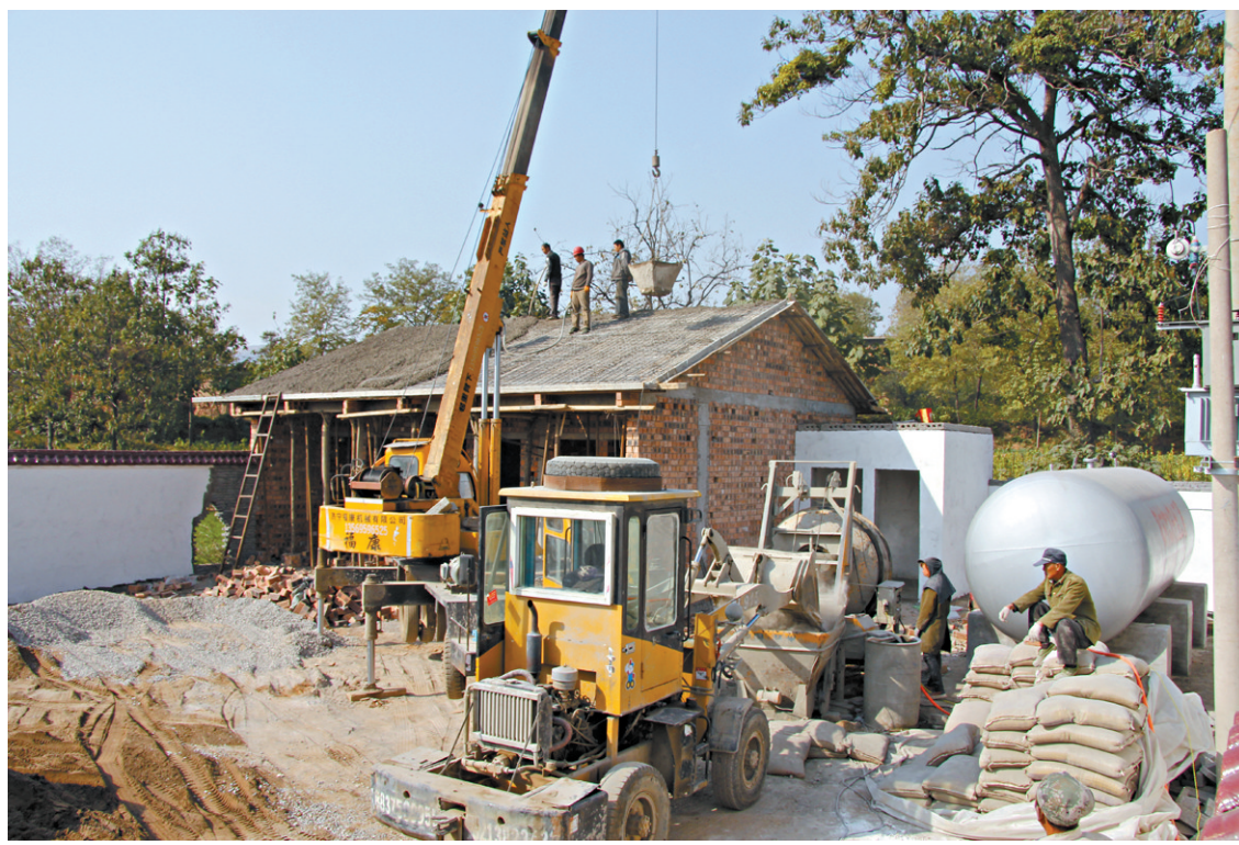
建供水厂 饮安全水
