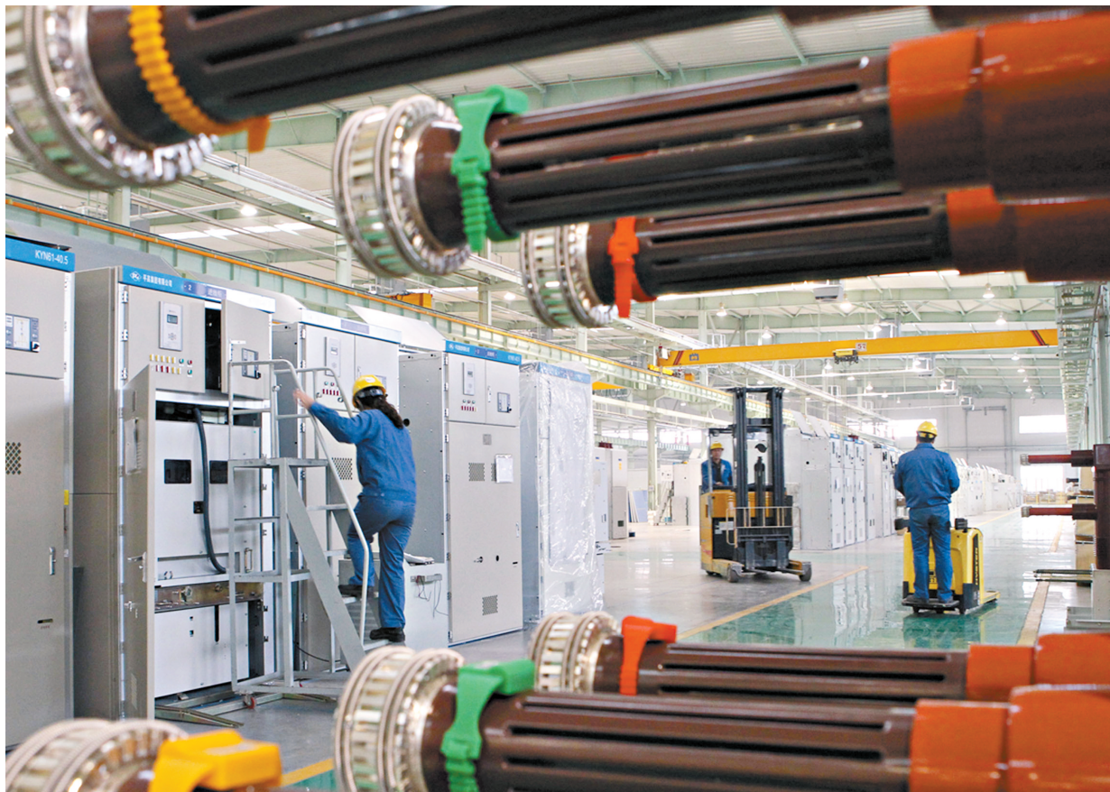
11月25日,职工在开关柜厂成套电器装配流水线旁作业。 今年前10个月,该公司新增合同7.26亿元,实现营业收入5.29亿元,利润总额完成1579万元。 本报记者 李志勇 摄
