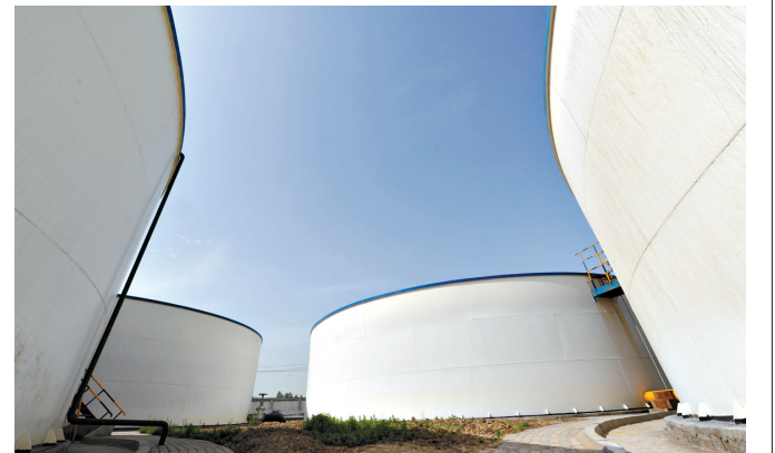
位于田庄乡的平煤神马集团采卤基地
