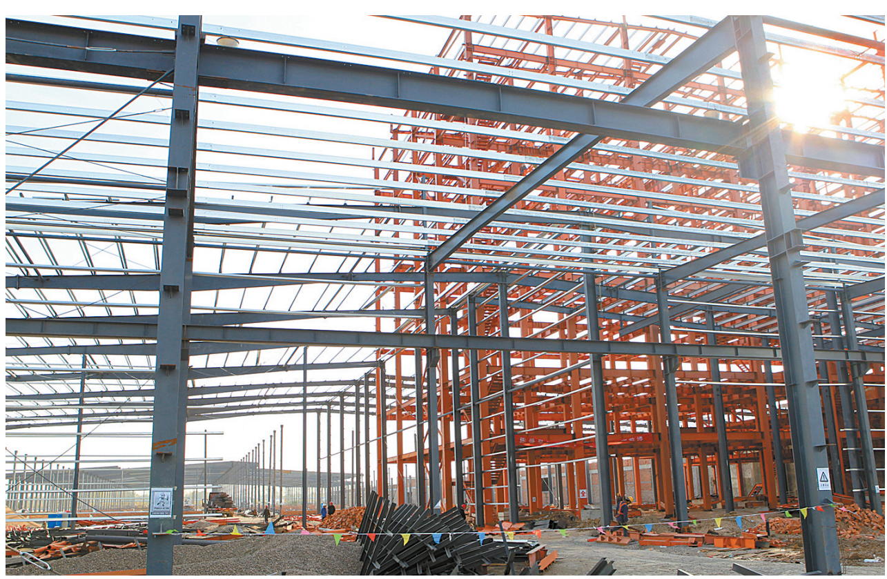
11月21日,施工人员在建设钢混结构厂房。平项山神马帘子布发展有限公司二期工程位于平项山产业集聚区,于今年5月份奠基开工。工程计划总投资6亿元,建设规模为捻织生产能力每年2.4万吨,尼龙66浸胶帘子布生产能力每年3万吨。项目建成投产后,对平煤神马集团做大尼龙化工产业,打造技术含量高、循环经济特征明显的煤基尼龙化工产业链具有重要意义。
