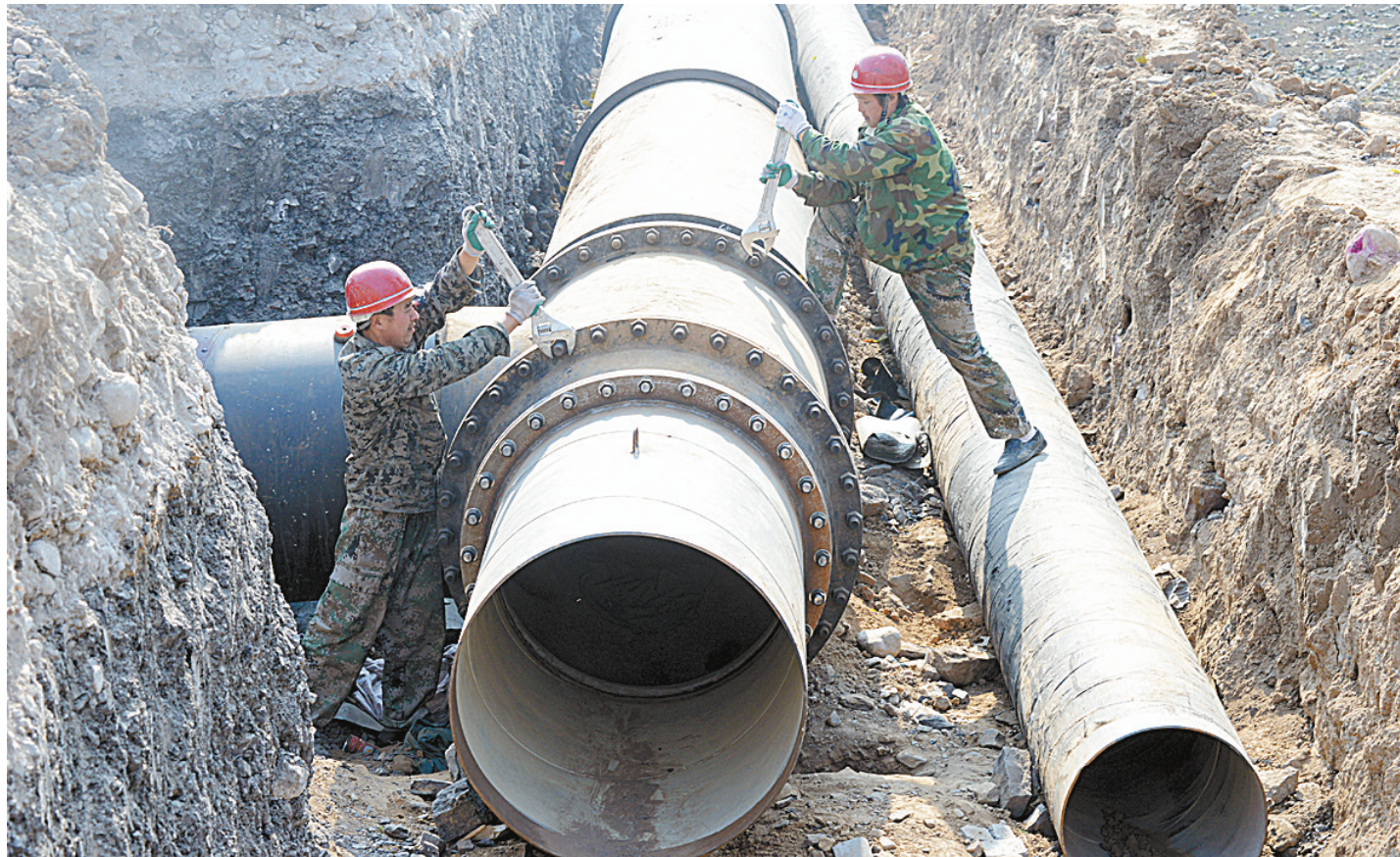
加紧建设平顶山化工产业集聚区供水工程
