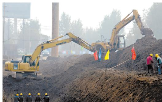
11月18日,两台挖掘机接力施工。淇河综合治理工程高庄沟至李苗路段排污管道铺设工程全长2.6公里。施工单位克服岩石硬度高、地下水水位浅等不利因素,增派人员、机械,连续作战,全力确保按期完工。 本报记者 王尧 摄
