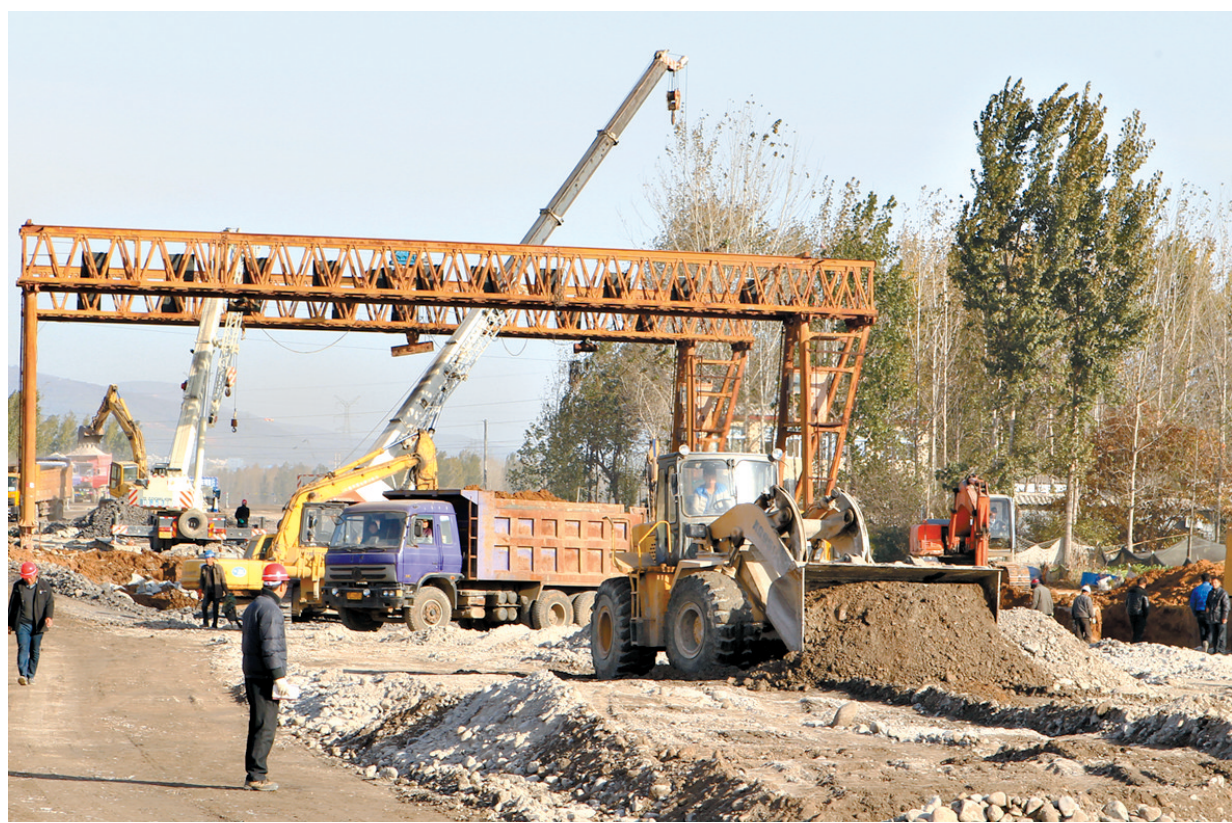
11月13日,施工人员在神马大道东延跨沙河大桥工程施工现场修筑引桥。神马大道东延工程是连接市区和东延跨沙河大桥工程的重要通道,其中跨沙河大桥于2013年8月开工,预计工期为15个月,本月底可具备基本通车条件。本报记者 姜涛 摄
