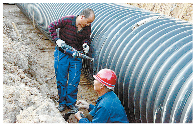
铺设排污管道
