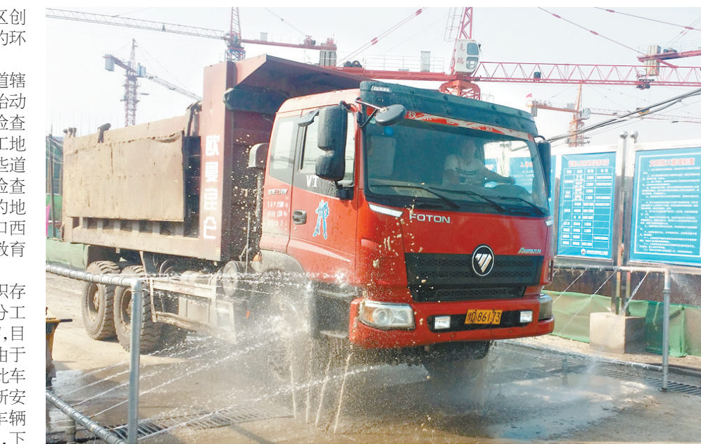
明珠世纪城二期工地车辆冲洗设备已投入使用。本报记者 牛智广 摄
