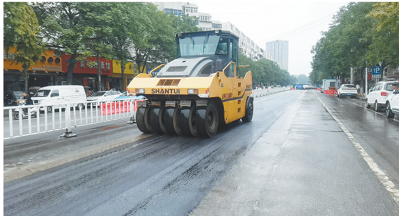
7月10日,在市区开源路中段,工作人员驾驶胶轮压路机碾压沥青混凝土。
