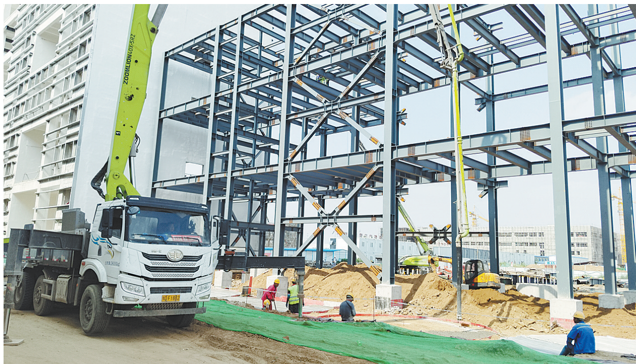
项目加紧建设
