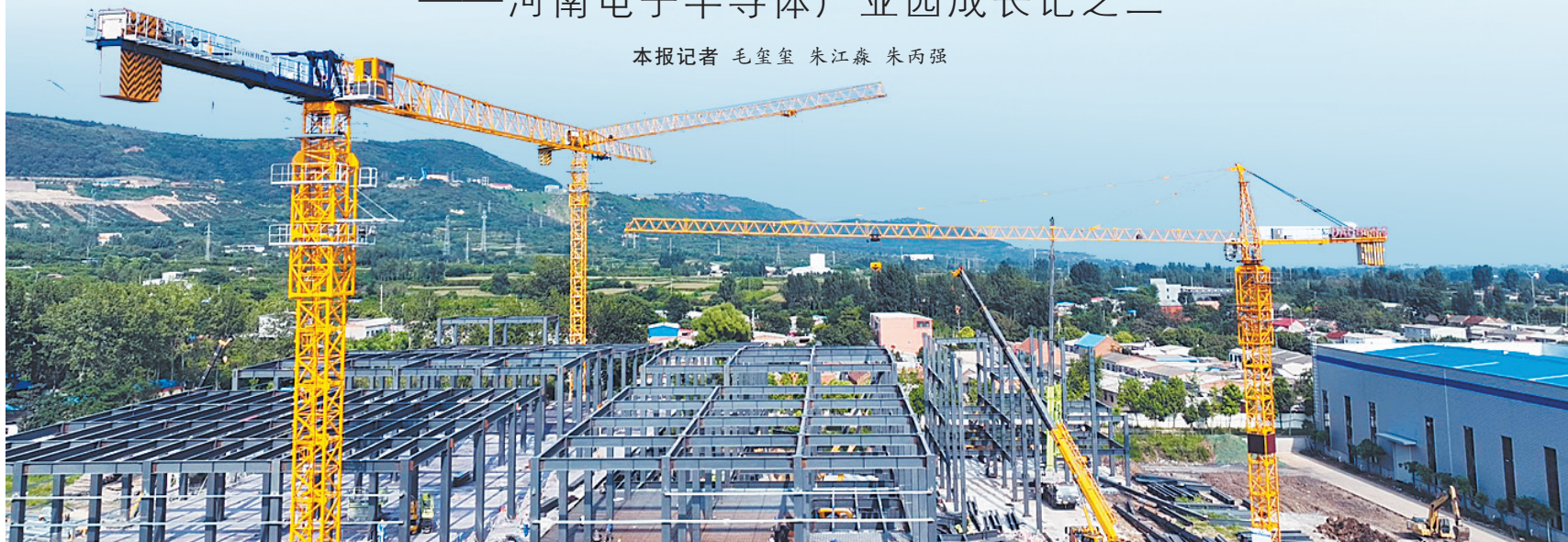
中宜创芯厂房钢构吊装
