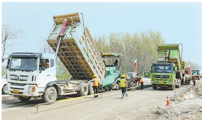
4月10日,施工人员在平鲁快速通道项目工地驾驶自卸车、摊铺机铺设水稳层。
