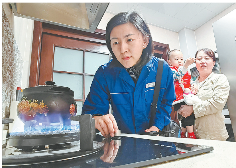
平顶山燃气有限责任公司卫东营销分公司员工(左一)在进行户内燃气设施安全检查 本报记者 姜涛 摄
