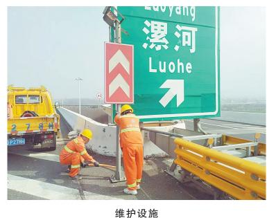
2月26日,在S88郑栾高速平 顶山段K117+400下行处,中原高 速平顶山分公司养护人员在对倾 倒的标识牌进行修复加固。
