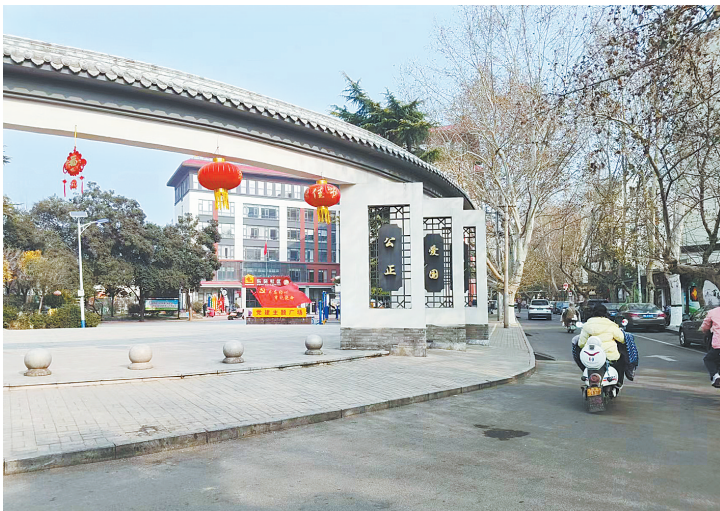
改造后的卫东区东安路街道东苑社区 市城镇老旧小区改造工作领导小组办公室供图
