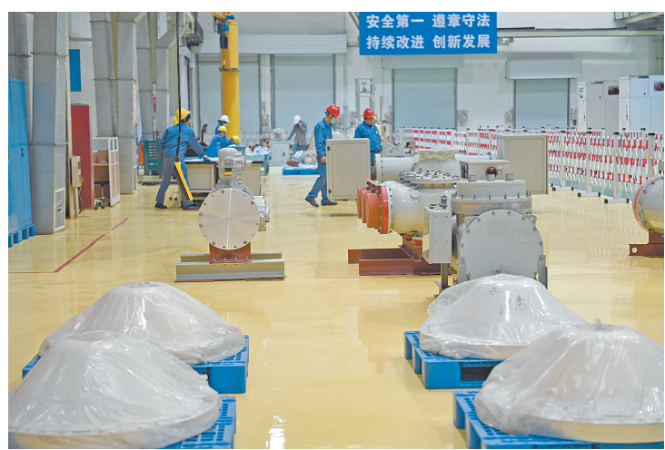
对配电网设备进行仿真试验
